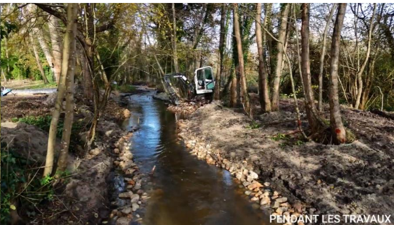
Convergence du bief et du bras naturel au pieds du moulin (vue amont-aval) – Retrait d'un batardeau (2 initialement) - Aspect paysager inchangé
