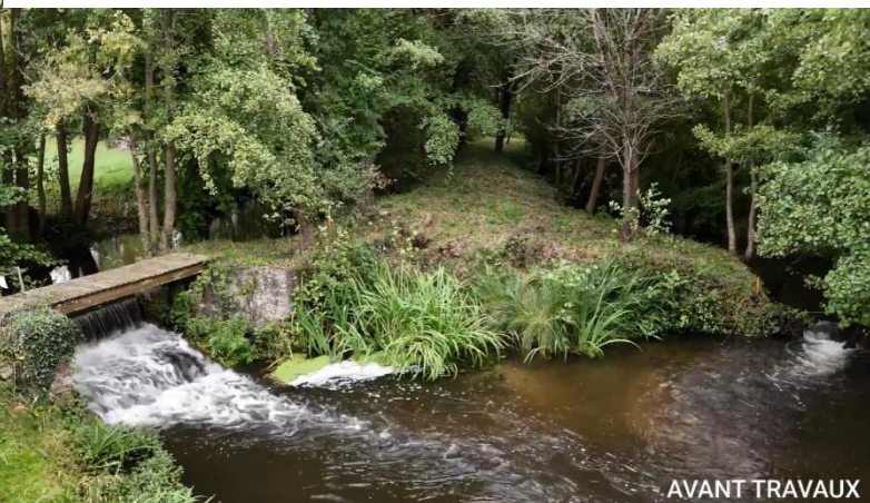
Convergence du bief et du bras naturel au pieds du moulin (vue amont-aval) – Retrait d'un batardeau (2 initialement) - Aspect paysager inchangé
