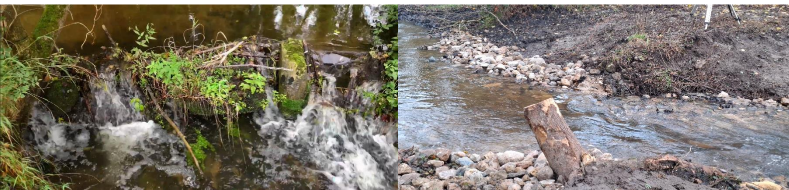
Ouvrage de répartition amont à la maçonnerie dégradée supprimé et remplacé par un radier (avant / pendant travaux)
