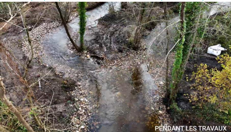
Convergence du bief et du bras naturel au pieds du moulin (vue amont-aval) – Retrait d'un batardeau (2 initialement) - Aspect paysager inchangé
