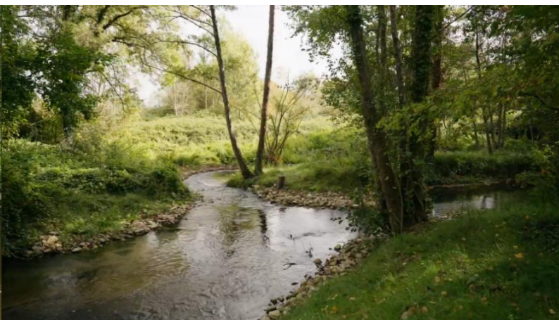
Bief (à droite) et bras naturel après les travaux (vue amont-aval)
