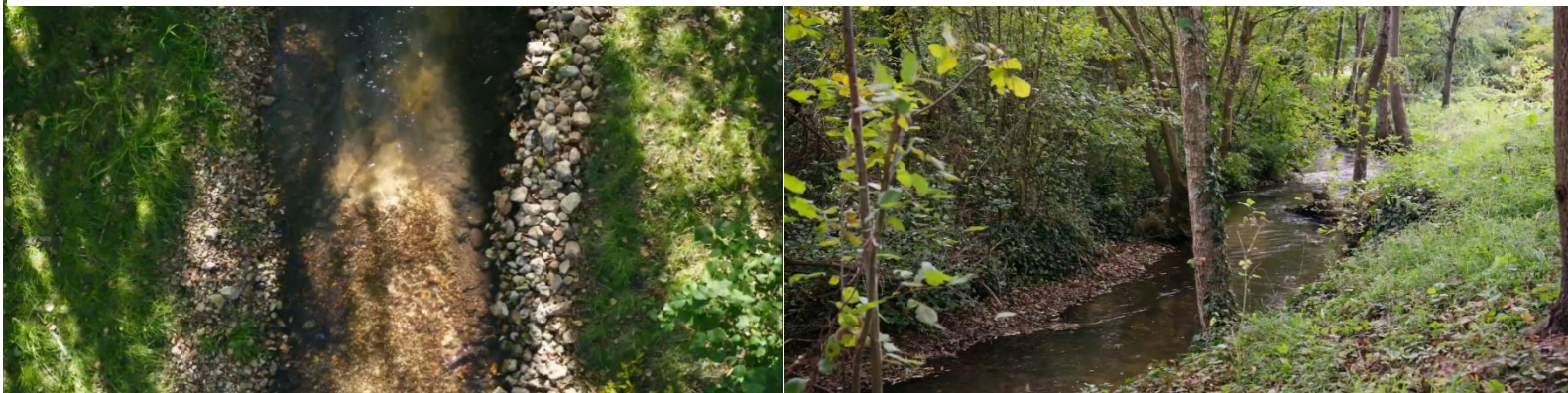
Bief – rétrécissement du lit par l'aménagement de banquettes pour diversifier les écoulements 2 mois et 1 an après les travaux (vue amont-aval)
